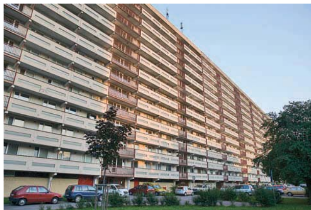
Obr. 12. Hradec Králové (okres Hradec Králové), sídliště Labská kotlina 2. Atypický deskový dům s pavlačemi na severní fasádě přístupnými nikoliv přímo z bytů, ale z chodeb. (Foto: Jan Rasch, 2014)
