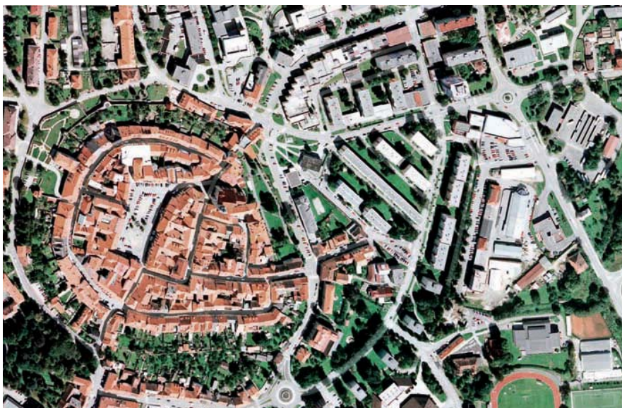
Obr. 11. Prachatice (okres Prachatice). Konfliktní sousedství mimořádně cenného historického jádra a panelového sídliště bez zjevných urbanistických kvalit. (Ortofoto převzato z www.google.cz/maps , stav v r. 2015)
